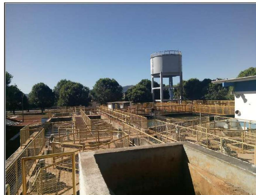
**Figura 32: Vista geral do bloco hidráulico e detalhe ao fundo do reservatório de distribuição utilizado para retrolavagem dos filtros.**
