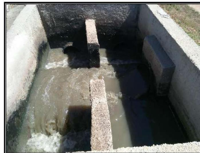
Figura 48: Caixa de Chegada do Esgoto.
