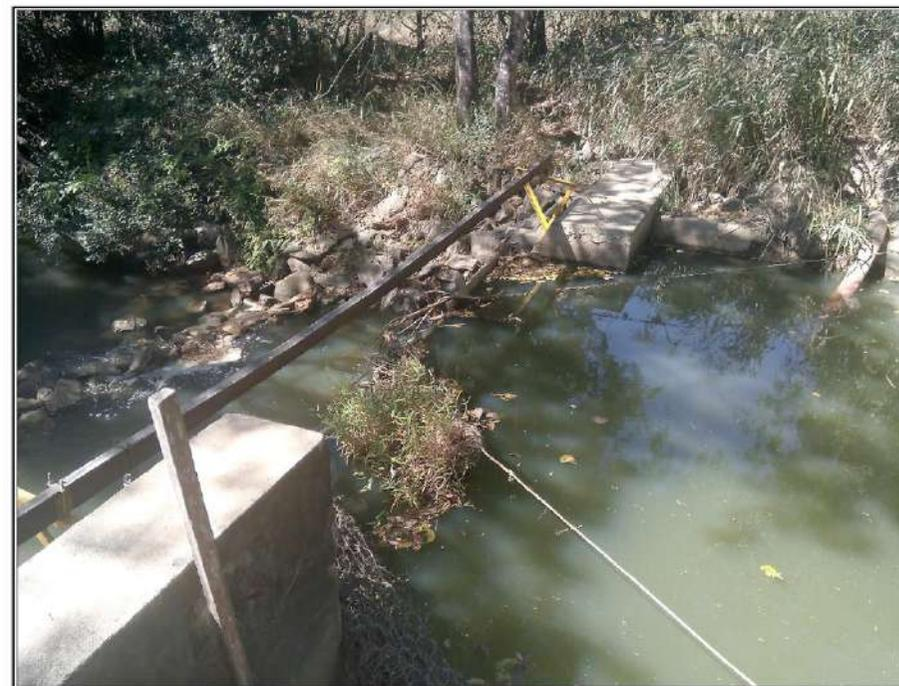
Figura 21: Captação de Água Bruta no Ribeirão Anda Só.
