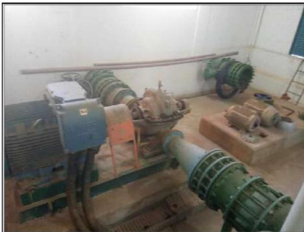
Figura 25: Estação Elevatória de Água Bruta – Poço seco 2ª etapa.
