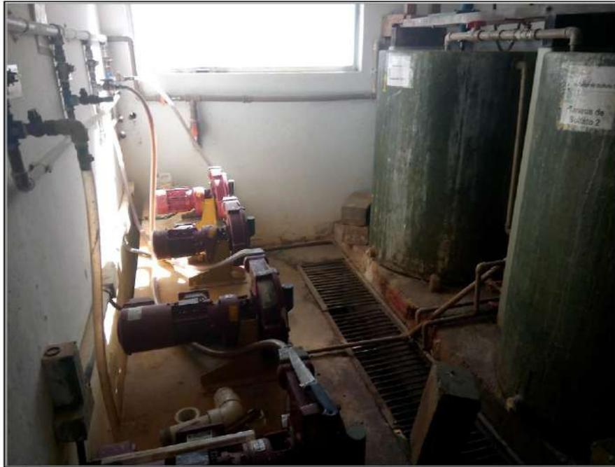
**Figura 35: Tanques de produtos químicos e Bombas Dosadora.**
