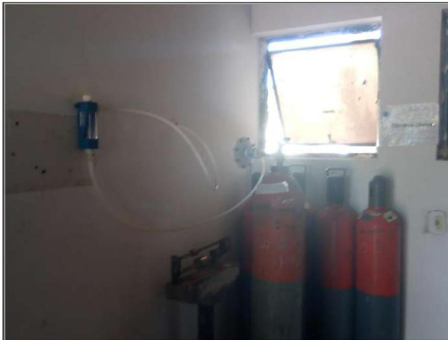
**Figura 33: Cilindros de Gás Cloro.**
