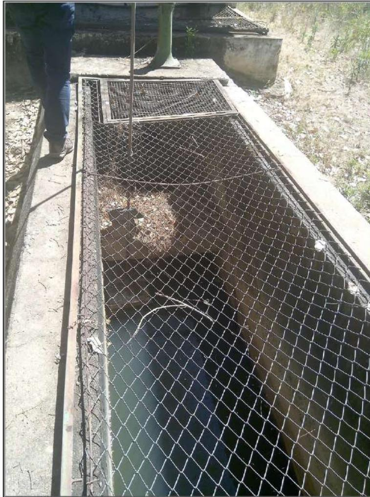
**Figura 22: Tomada de Água Bruta – Canal de Concreto.**
