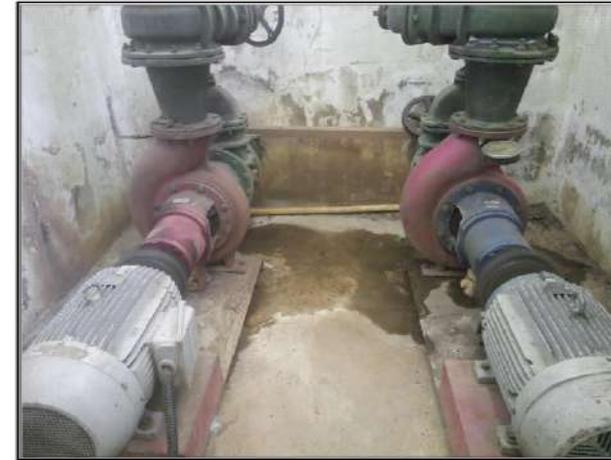
**Figura 23: Estação Elevatória de Água Bruta – Poço Seco 1ª etapa.**
