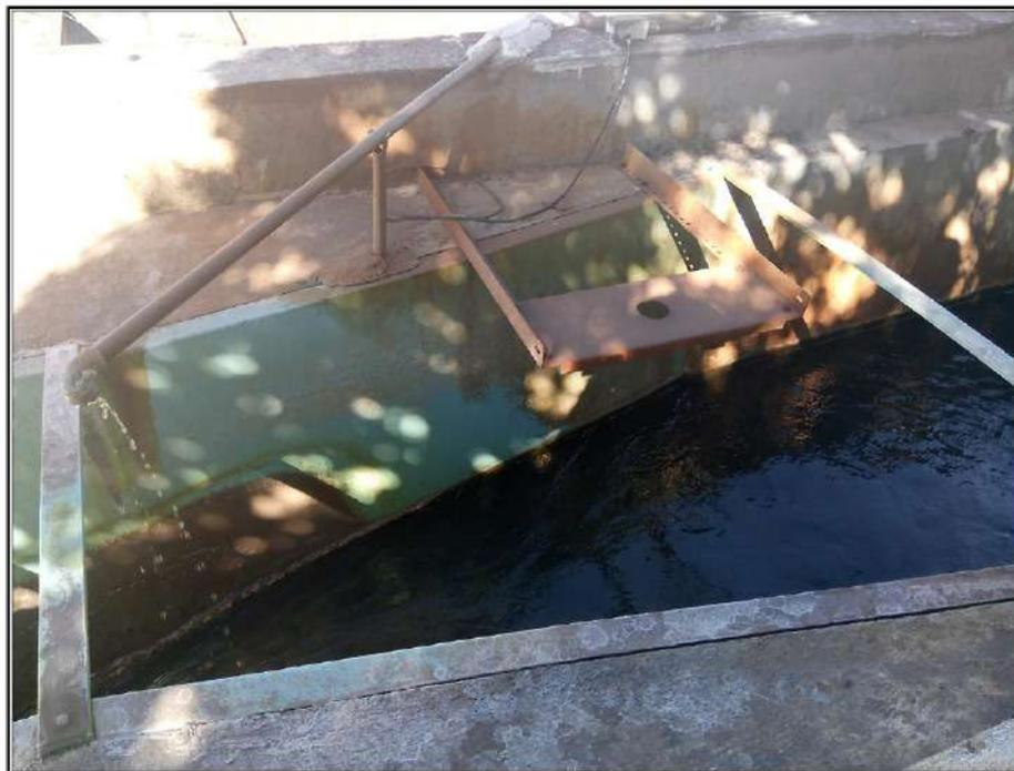
**Figura 27: Entrada de Água Bruta na Calha, detalhe da dosagem de sulfato de alumínio e vestígios da instalação de medidor Ultrassônico.**
