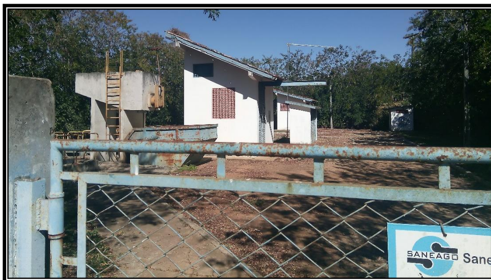
Figura 41: EEE-Final – Entrada da Estação.
