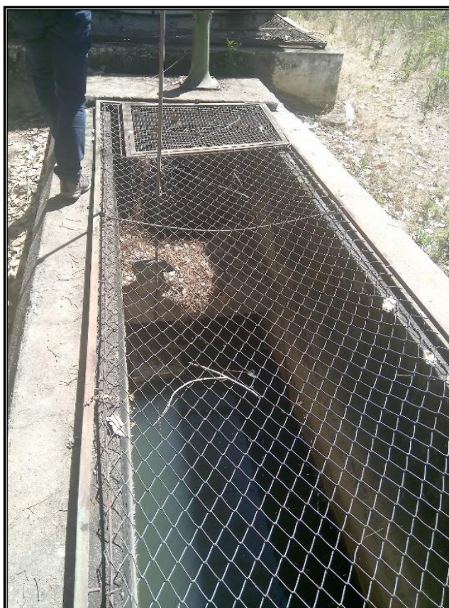
Figura 12: Tomada de Água Bruta – Canal de Concreto.
