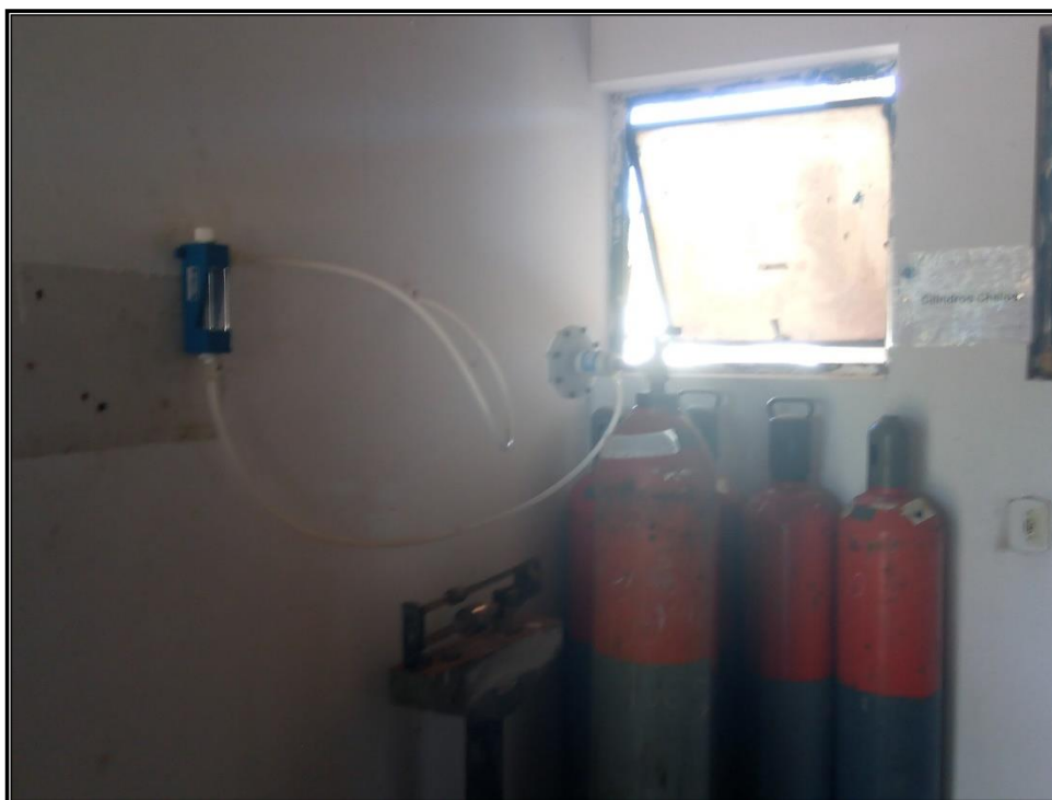
Figura 23: Cilindros de Gás Cloro.
