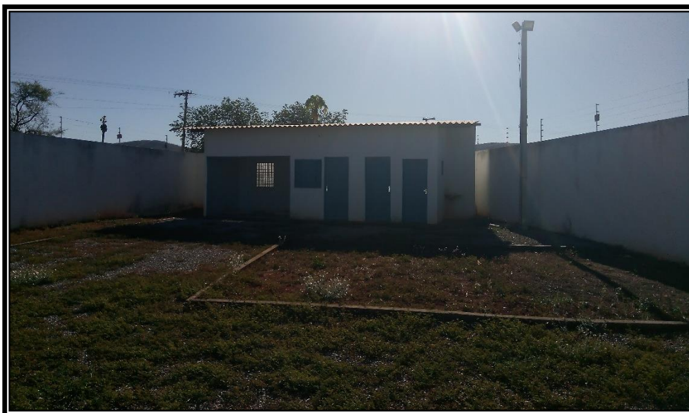
Figura 39: EEE-Ype – Entrada da Estação.
