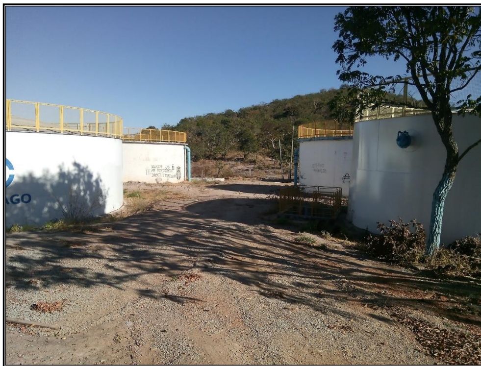
Figura 25: Centro de Reservação Morro da Ema.
