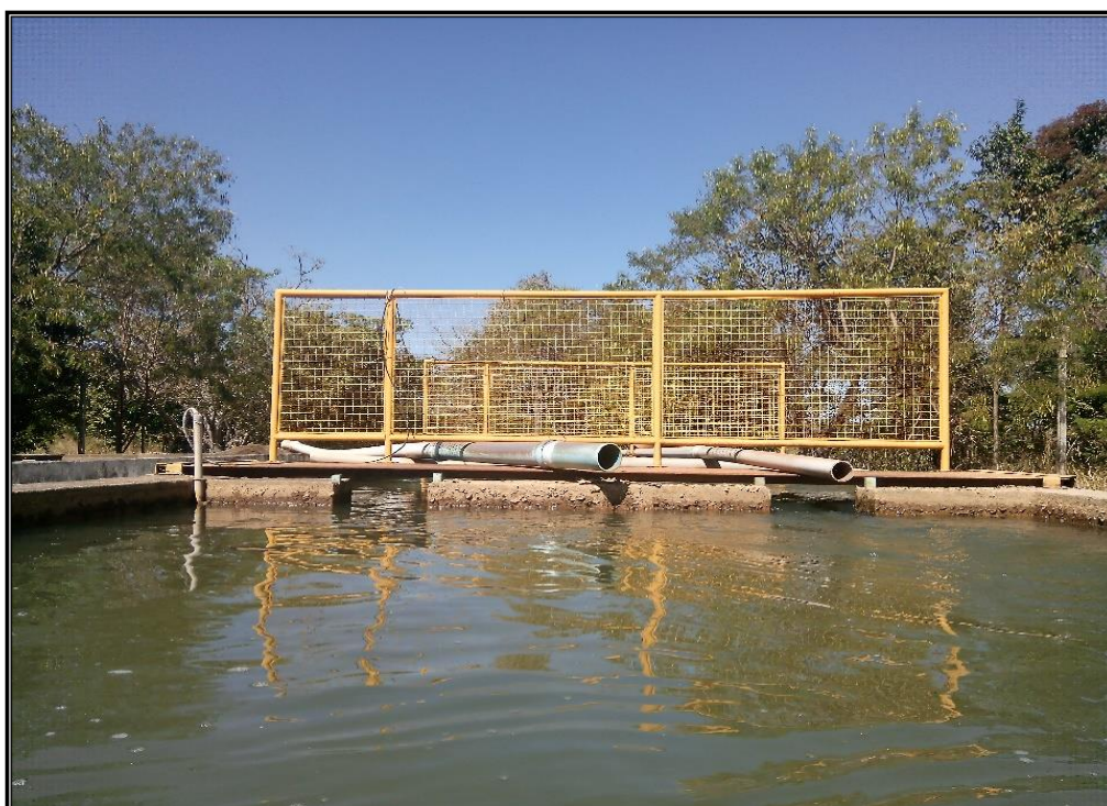
Figura 14: Tanque de Equalização de Água Bruta.
