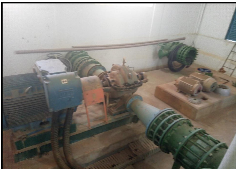
Figura 15: Estação Elevatória de Água Bruta – Poço seco 2ª etapa.
