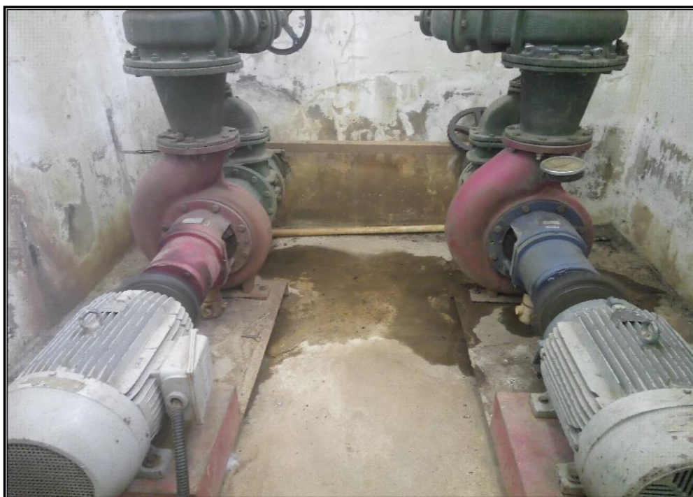
Figura 13: Estação Elevatória de Água Bruta – Poço Seco 1ª etapa.
